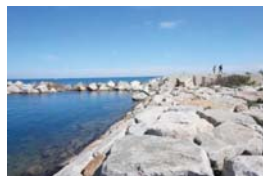
Wave-breakers Zona de Banyes del Fòrum, Barcelona
